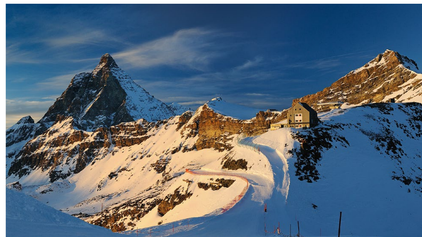
Festungsbaute auf dem Theodulpass, mit den heute noch sichtbaren Überresten der Schiesscharten und dem Hotel Steinbock.
